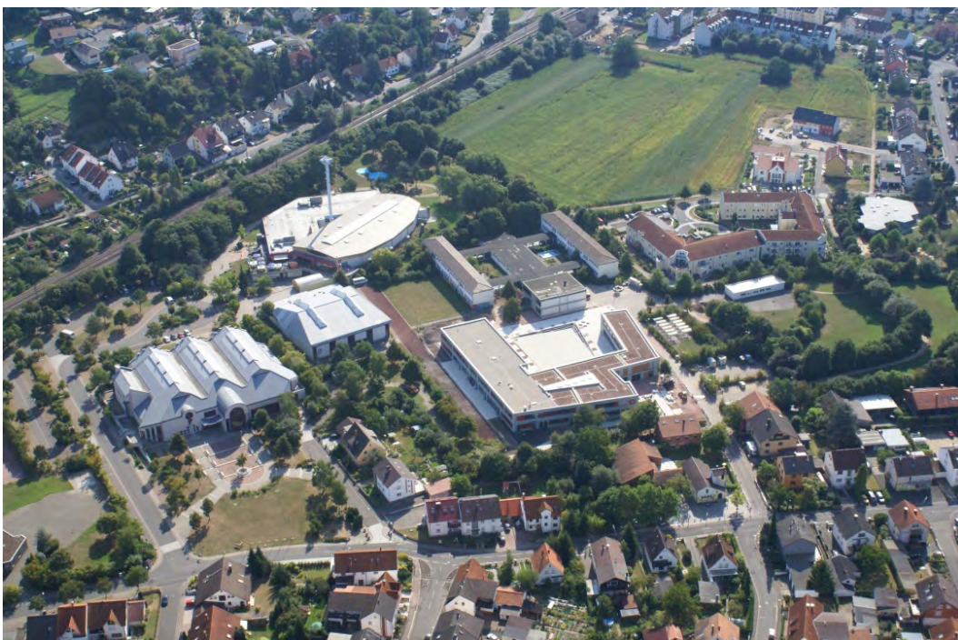
Luftaufnahme im September 2009 vor Abriss der alten Ketteler-Schule
