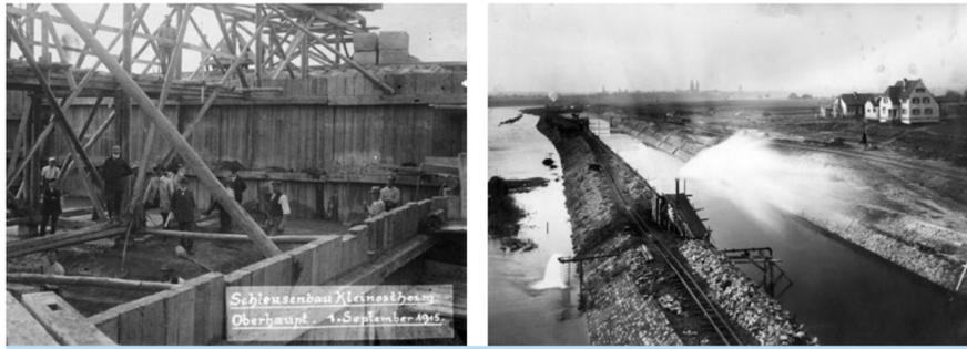
Beim Schleusenbau 1915-17 wurde der Fluss durch ein Nadelwehr aufgestaut. Dies ist eine Sonderform eines Wehres und muss im Gegensatz zum festen Wehr den Flusslauf nicht vollständig absperren. Es besteht aus einer Reihe von in den Fluss gesetzten Holzplanken (Nadeln). Die Durchflussmenge wird durch Wegnehmen oder Hinzufügen von Nadeln reguliert.
