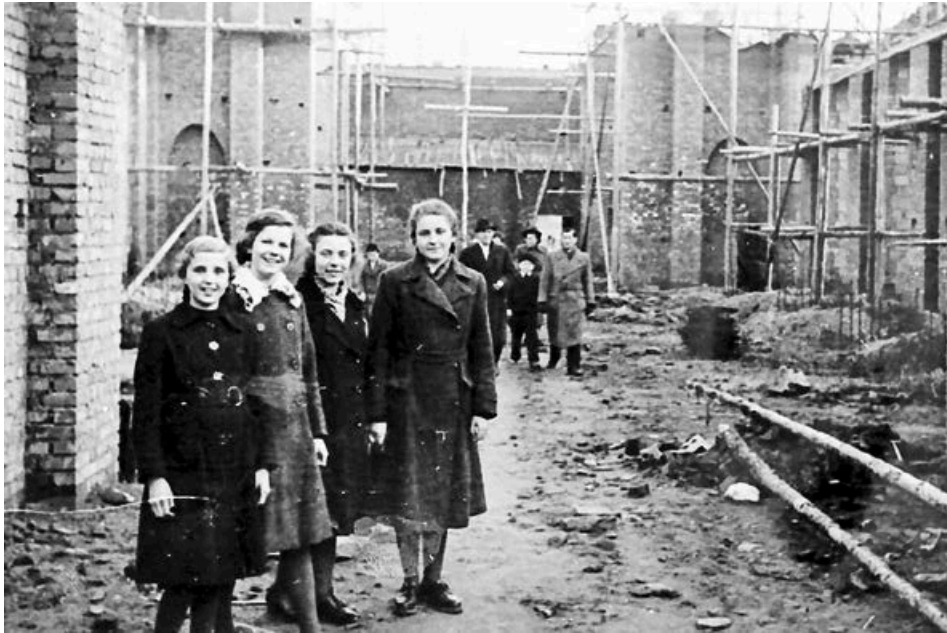
Das Begehen der Baustelle war damals möglich ...
